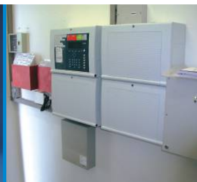
oben links: Vernetzte Brandmeldezentrale
